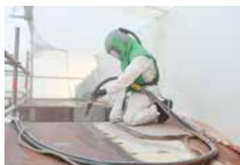
Le décapage de peinture au plomb est un processus crucial pour éliminer les anciennes couches de peinture contenant du plomb, potentiellement nocives. Nous préparons la surface par sablage, aérogommage, ou hydrogommage, afin de la rendre idéale pour l'application de peintures anticorrosion. Cette préparation minutieuse assure une protection durable et efficace contre la corrosion.
